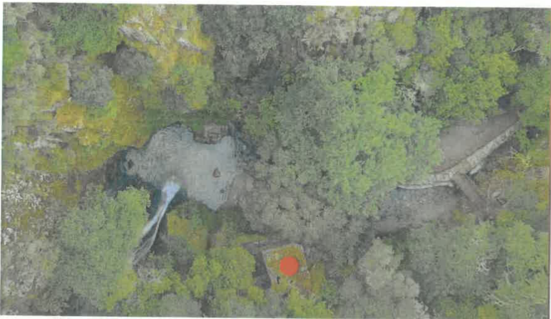
Foto 1 ● local onde se encontra implantado o moinho. -----
