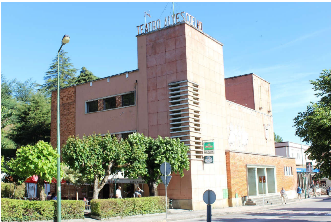
Figura 15 Fachada lateral sul do Teatro Alves Coelho
