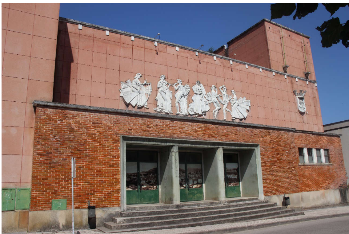
Figura 12 Fachada principal (nascente) do Teatro Alves Coelho
