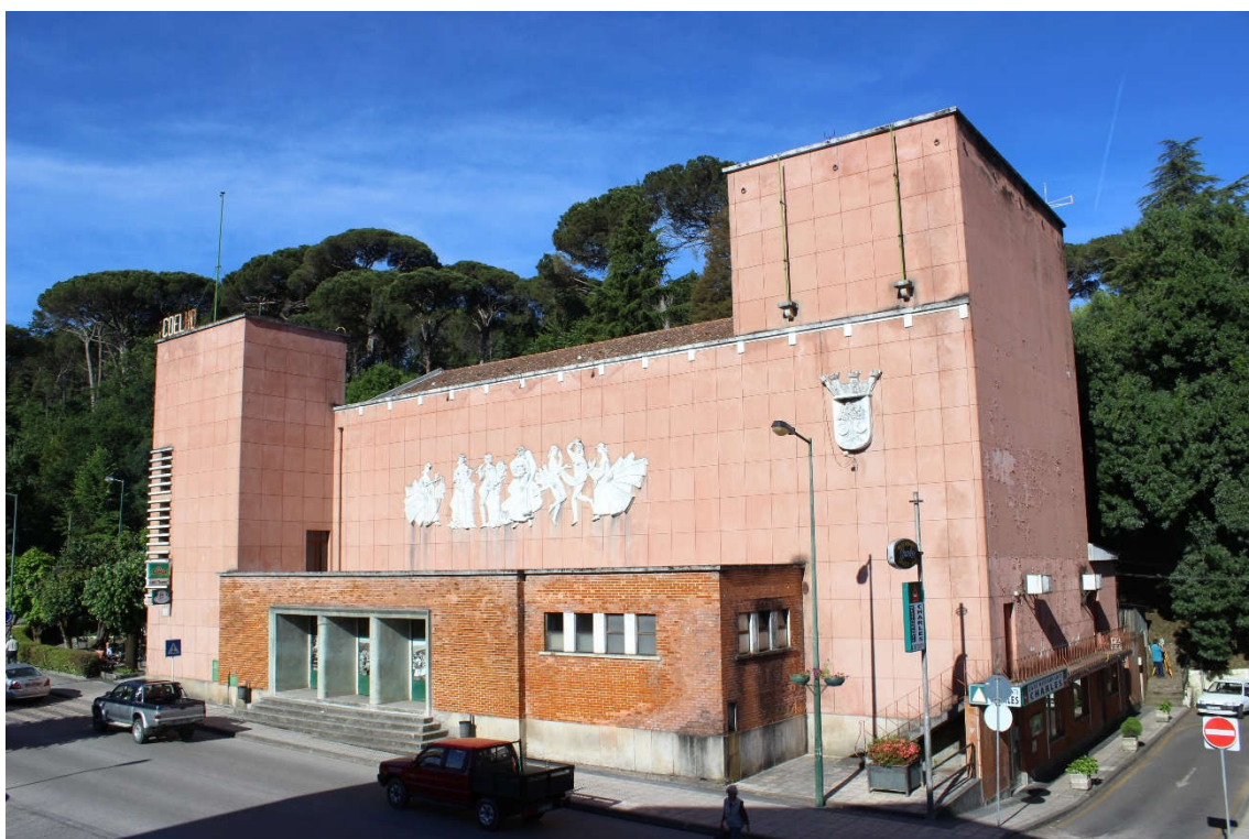
Figura 13 Fachada principal e lateral norte do Teatro Alves Coelho
